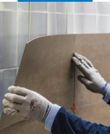
Posa di LVT a parete
