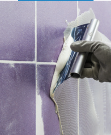
Stesura di Ultrabond Eco MS 4 LVT Wall su supporto non assorbente con spatola dentata
